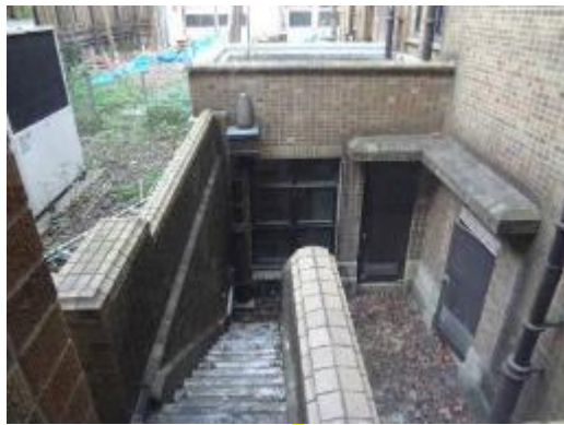
1号館中庭の地下室
