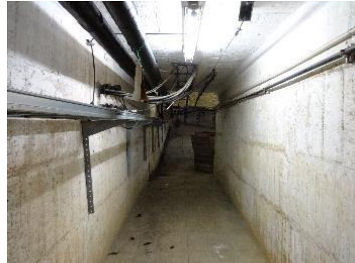
地下トンネル
